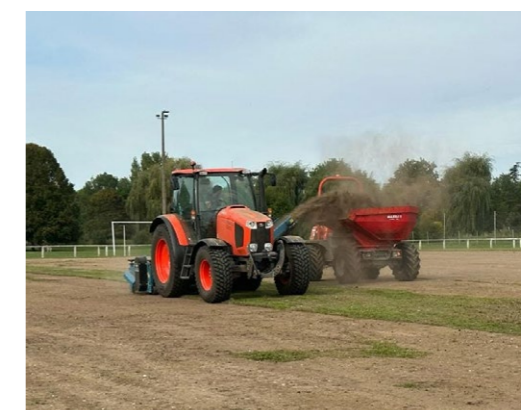
Réhabilitation du terrain de football et installation arrosage automatique Coût des travaux : 69 480 € HT Fonds de concours alloué par l'EPN : 11 300 € HT.
