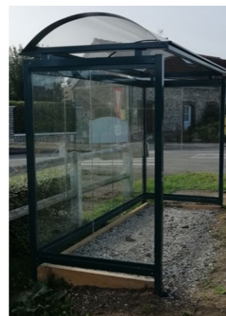
Abri bus rue Aristide Briand Réalisé et financé par BUEIL COM.
