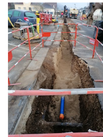
Renouvellement des canalisations d'eau potable rue Edouard Branly Réalisés et financés par le SIAEVE.
