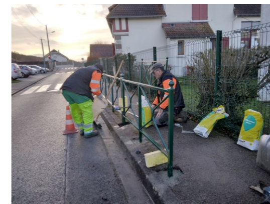
Installation de barrières aux abords des écoles Réalisés par les agents du service technique.
